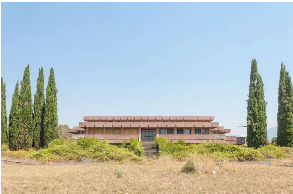
ASI Caserta - North Volturno Agglomerate_ Industrial Complex Ceramica Pozzi | Ph Mariano De Angelisi and Francesco Cimmino, 2017
